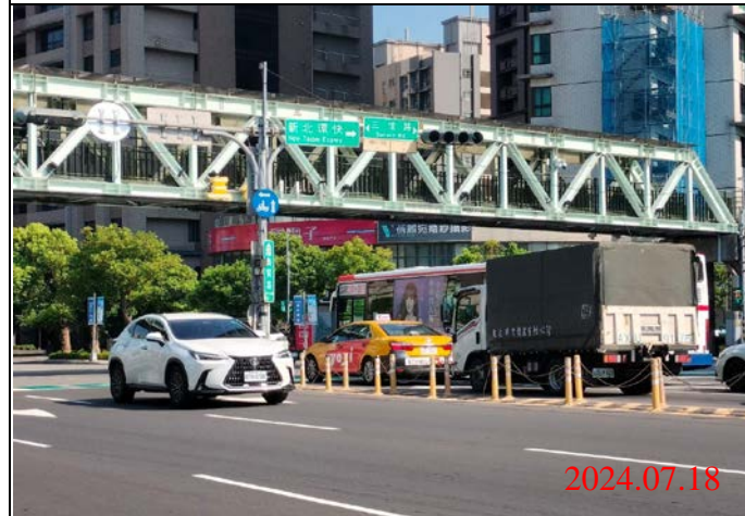
巡查日期地點：113.07.18/ Y23車站 照片說明：牌面設置狀況
