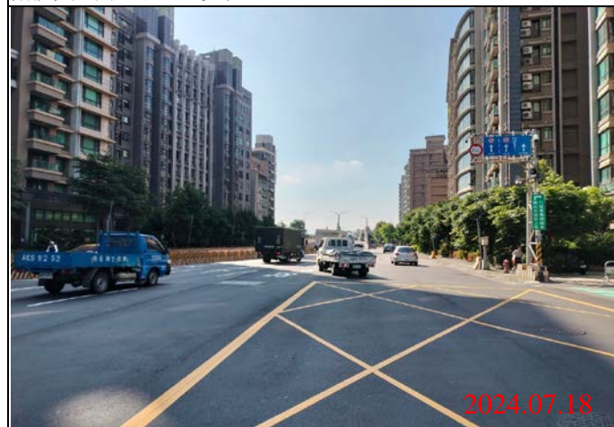
巡查日期地點：113.07.18/ Y23車站 照片說明：路面狀況
