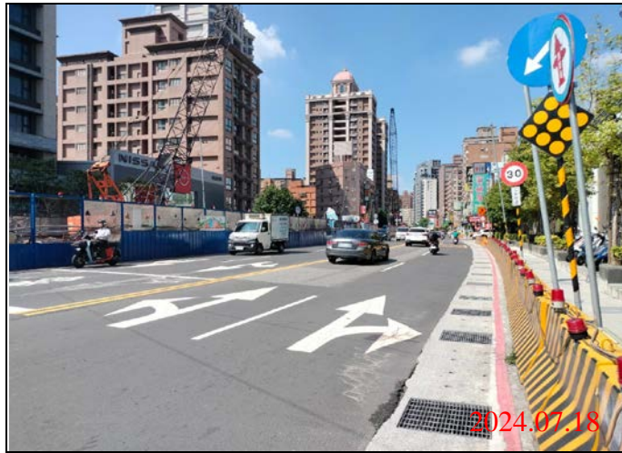
巡查日期地點：113.07.18/ Y22車站 照片說明：路面狀況
