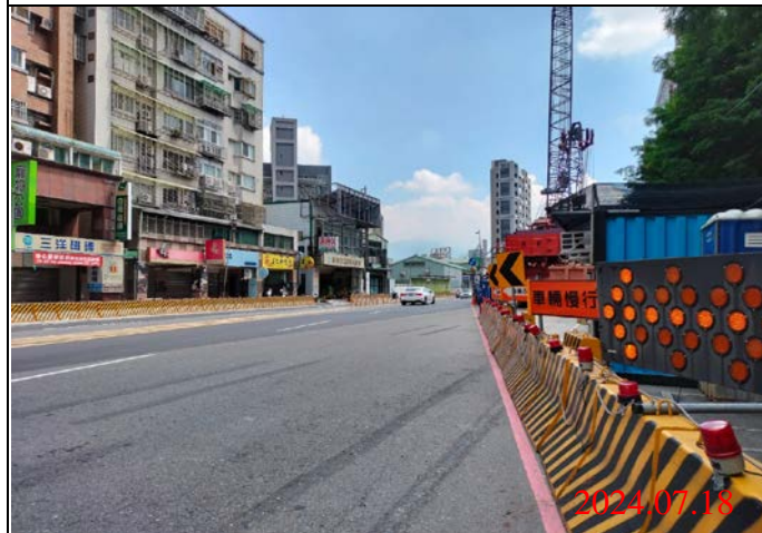
巡查日期地點：113.07.18/ Y22車站 照片說明：路面狀況
