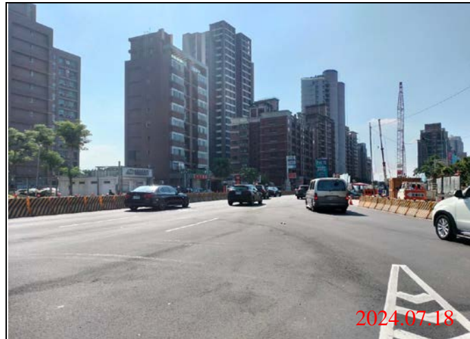
巡查日期地點：113.07.18/-23車站 照片說明：路面狀況
