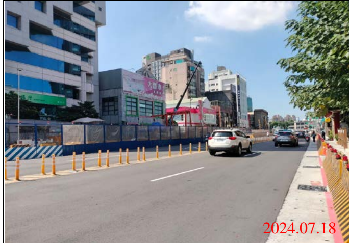
巡查日期地點：113.07.18/ Y21車站 照片說明：路面狀況
