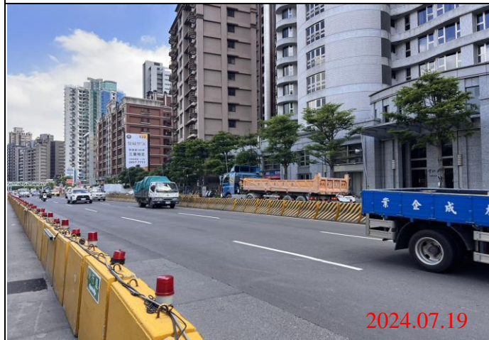
巡查日期地點：113.07.19/ Y23車站 照片說明：路面狀況
