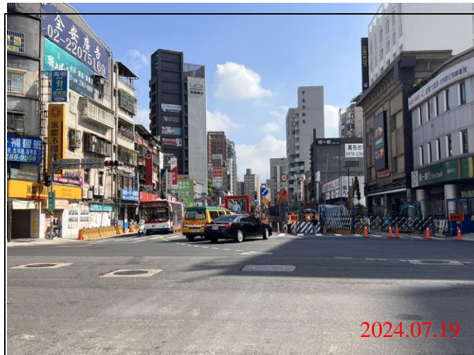
巡查日期地點：113.07.19/ Y21車站 照片說明：路面狀況
