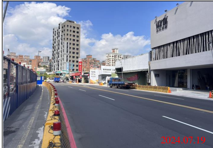
巡查日期地點：113.07.19/ Y22車站 照片說明：路面狀況
