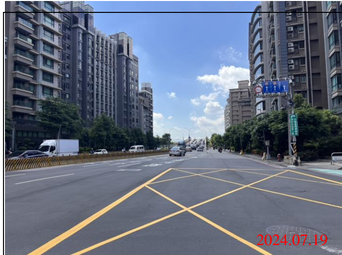
巡查日期地點：113.07.19/-23車站 照片說明：路面狀況
