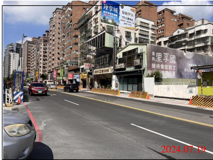
巡查日期地點：113.07.19/ Y22車站 照片說明：路面狀況
