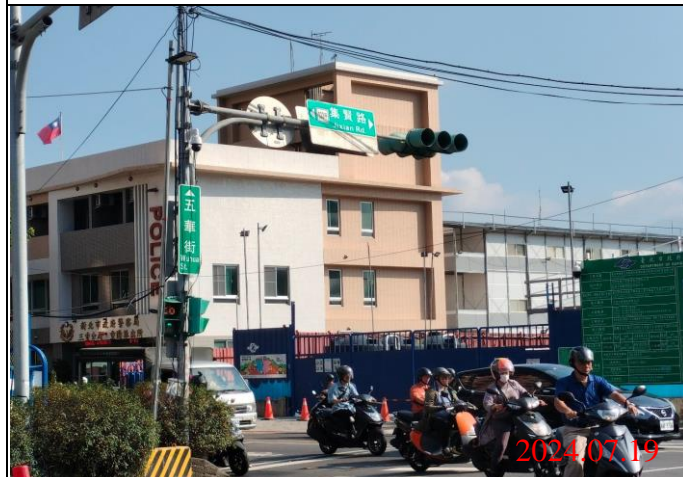
巡查日期地點：113.07.19/ Y22車站 照片說明：牌面設置狀況
