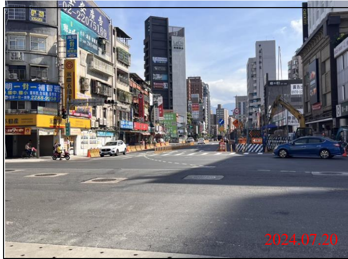
巡查日期地點：113.07.20/ Y21車站 照片說明：路面狀況
