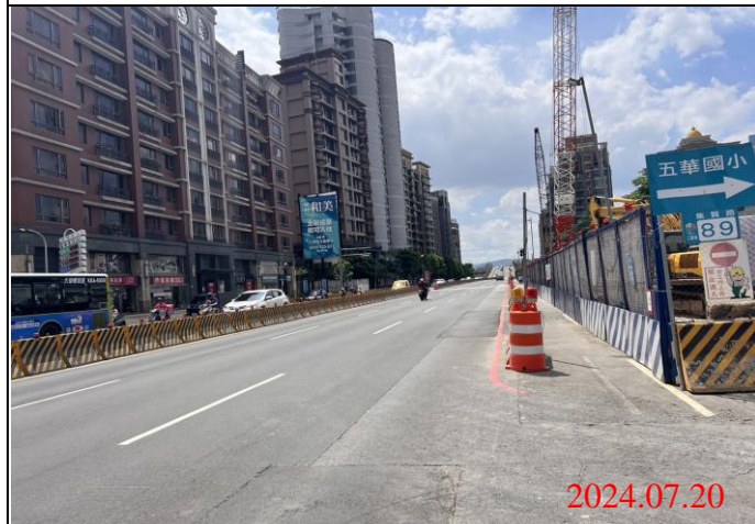
巡查日期地點：113.07.20/ Y23車站 照片說明：路面狀況
