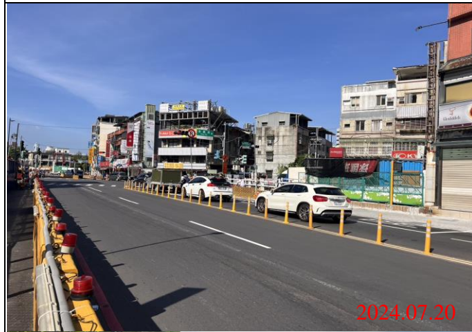
巡查日期地點：113.07.20/ Y21車站 照片說明：路面狀況
