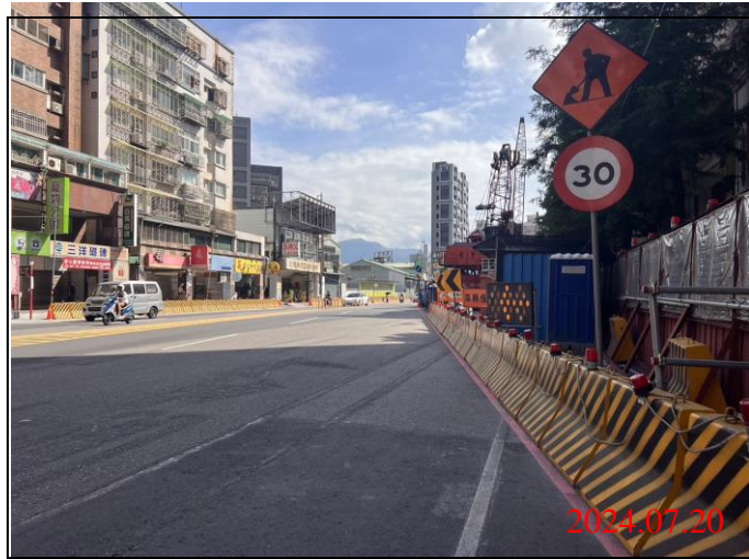
巡查日期地點：113.07.20/ Y22車站 照片說明：路面狀況
