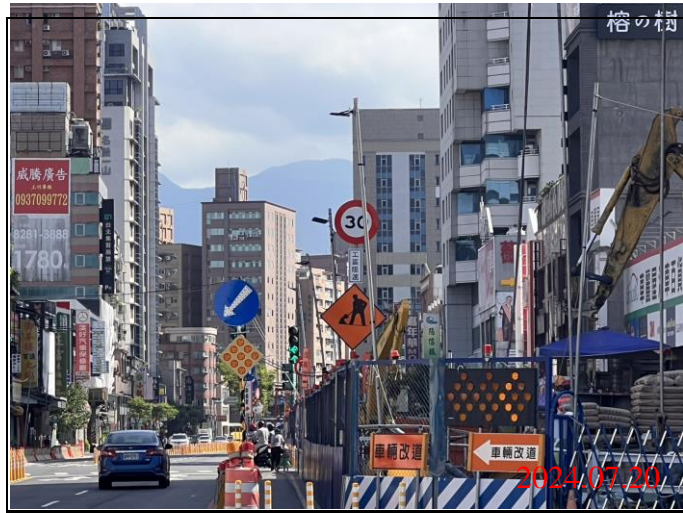
巡查日期地點：113.07.20/ Y21車站 照片說明：牌面設置狀況
