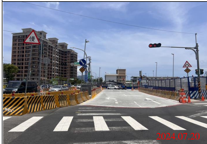
巡查日期地點：113.07.20/ Y22車站 照片說明：路面狀況
