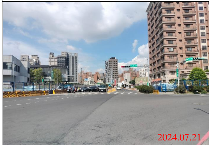
巡查日期地點：113.07.21/ Y22車站 照片說明：路面狀況
