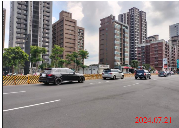
巡查日期地點：113.07.21/-23車站 照片說明：路面狀況
