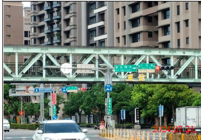
巡查日期地點：113.07.21/ Y23車站 照片說明：牌面設置狀況
