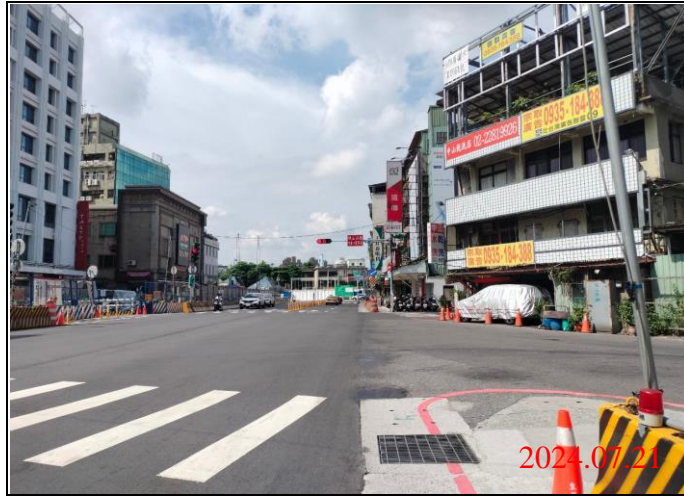
巡查日期地點：113.07.21/ Y21車站 照片說明：路面狀況
