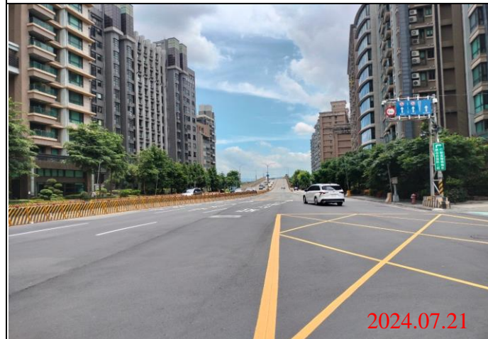
巡查日期地點：113.07.21/ Y23車站 照片說明：路面狀況
