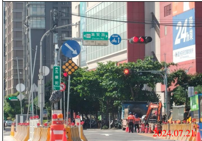
巡查日期地點：113.07.21/ Y22車站 照片說明：牌面設置狀況
