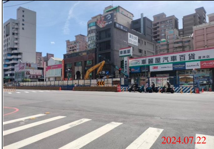
巡查日期地點：113.07.22/ Y21車站 照片說明：路面狀況
