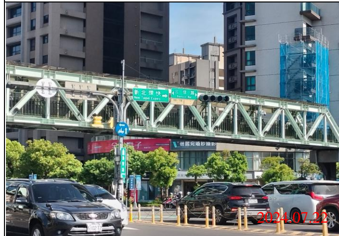
巡查日期地點：113.07.22/ Y23車站 照片說明：牌面設置狀況
