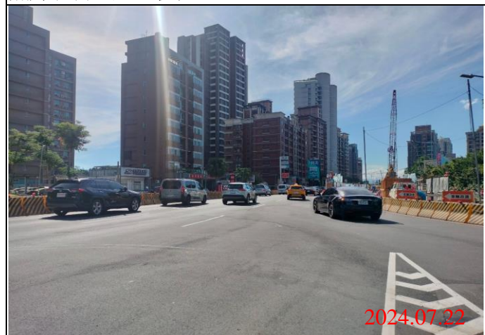
巡查日期地點：113.07.22/ Y23車站 照片說明：路面狀況
