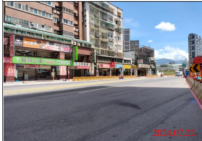
巡查日期地點：113.07.22/ Y22車站 照片說明：路面狀況
