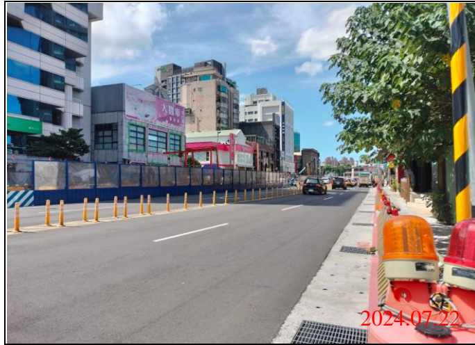
巡查日期地點：113.07.22/ Y21車站 照片說明：路面狀況
