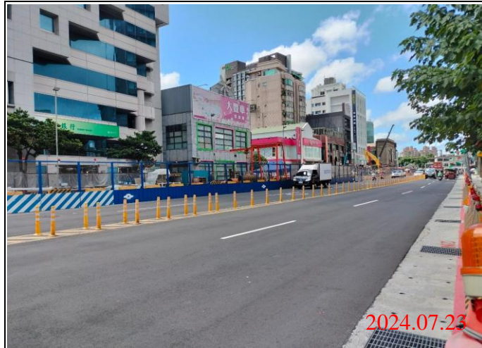
巡查日期地點：113.07.23/ Y21車站 照片說明：路面狀況
