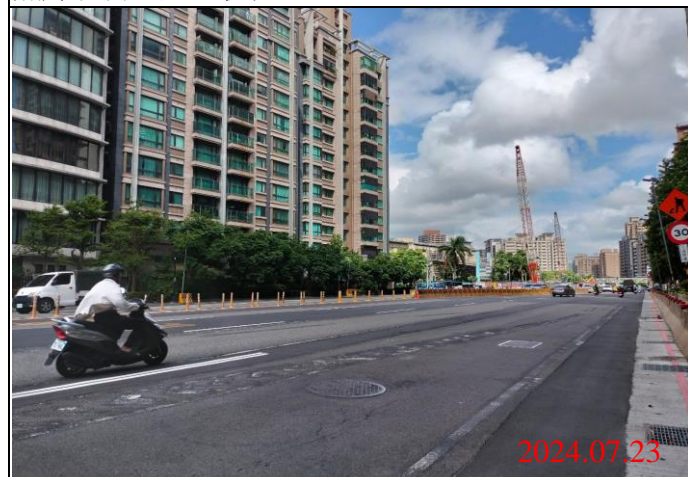
巡查日期地點：113.07.23/ Y23車站 照片說明：路面狀況
