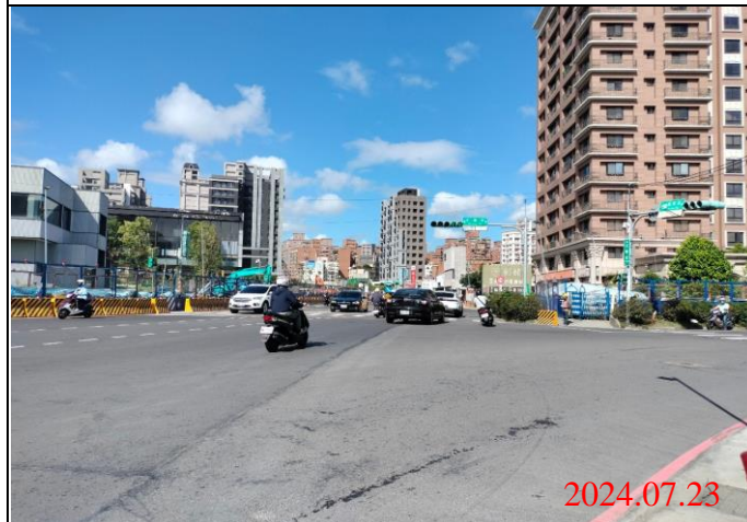
巡查日期地點：113.07.23/ Y22車站 照片說明：路面狀況
