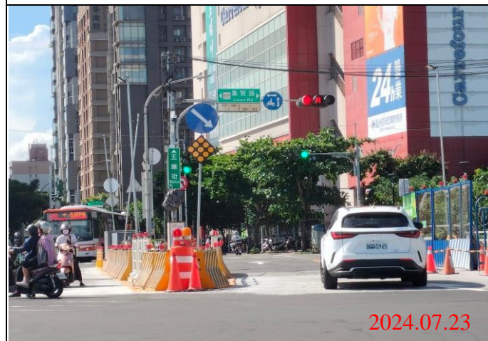
巡查日期地點：113.07.23/ Y22車站 照片說明：牌面設置狀況
