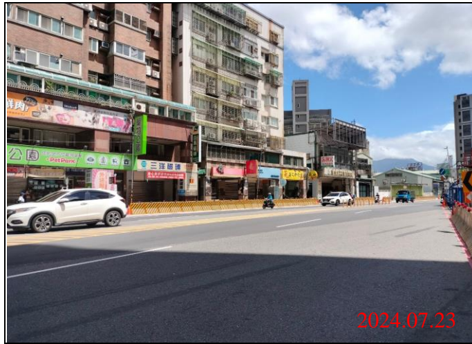
巡查日期地點：113.07.23/ Y22車站 照片說明：路面狀況
