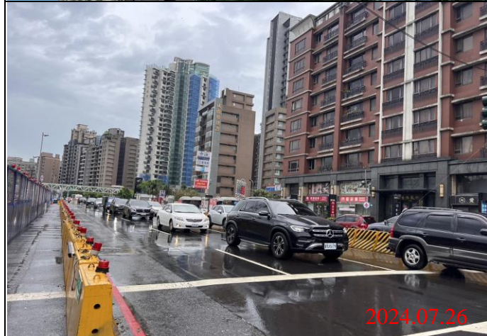
巡查日期地點：113.07.26/ Y23車站 照片說明：路面狀況
