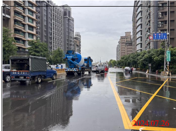
巡查日期地點：113.07.26/-23車站 照片說明：路面狀況
