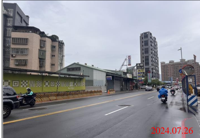
巡查日期地點：113.07.26/ Y22車站 照片說明：路面狀況
