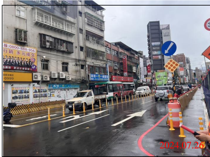
巡查日期地點：113.07.26/ Y21車站 照片說明：路面狀況
