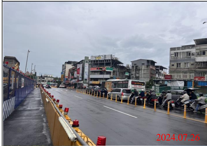
巡查日期地點：113.07.26/ Y21車站 照片說明：路面狀況
