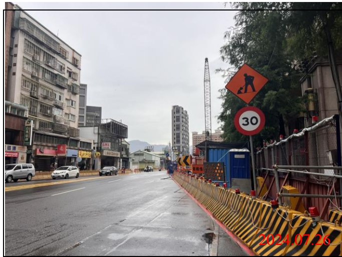
巡查日期地點：113.07.26/ Y22車站 照片說明：路面狀況
