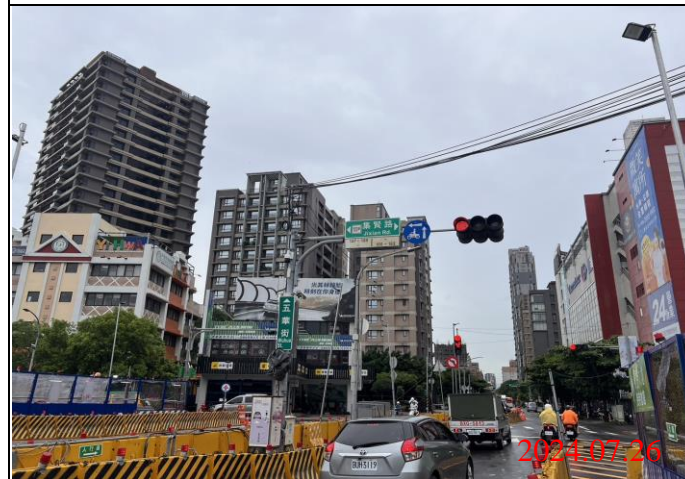
巡查日期地點：113.07.26/ Y22車站 照片說明：牌面設置狀況
