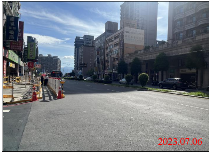
巡查日期地點：112.07.06/ Y22車站 照片說明：路面狀況
