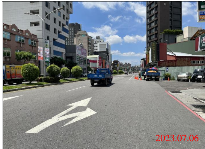
巡查日期地點：112.07.06/ Y21車站 照片說明：路面狀況
