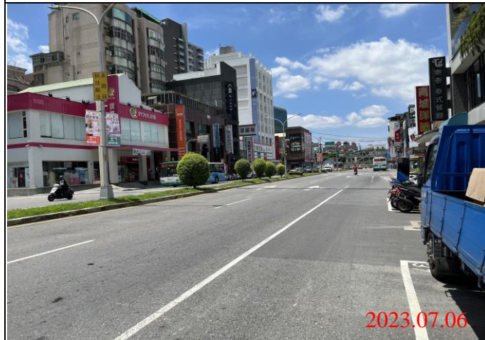
巡查日期地點：112.07.06/ Y21車站 照片說明：路面狀況
