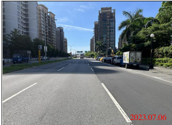
巡查日期地點：112.07.06/ Y23車站 照片說明：路面狀況
