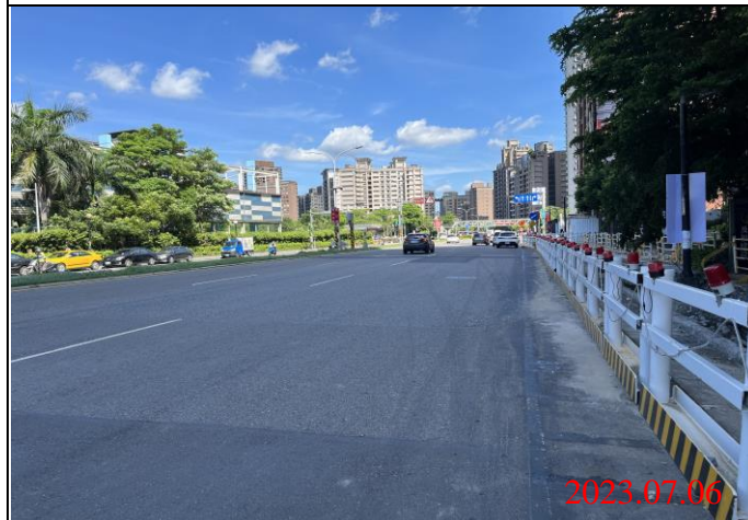
巡查日期地點：112.07.06/ Y23車站 照片說明：路面狀況
