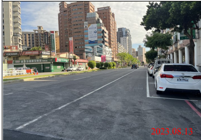
巡查日期地點：112.08.13/ Y21車站 照片說明：路面狀況
