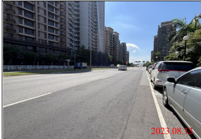
巡查日期地點：112.08.13/ Y23車站 照片說明：路面狀況
