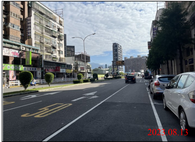
巡查日期地點：112.08.13/ Y22車站 照片說明：路面狀況
