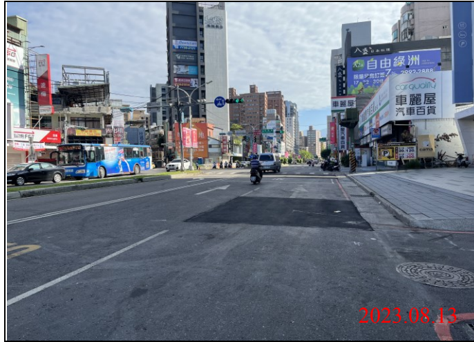
巡查日期地點：112.08.13/ Y21車站 照片說明：路面狀況
