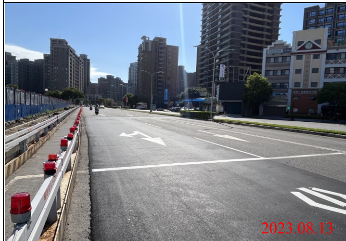
巡查日期地點：112.08.13/ Y22車站 照片說明：路面狀況
