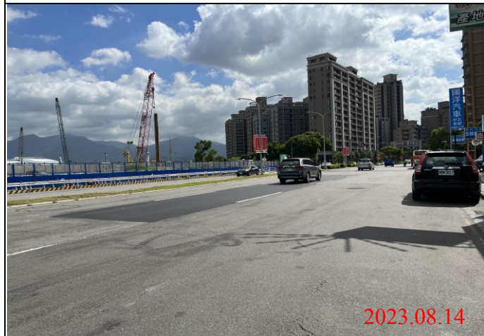
巡查日期地點：112.08.14/ Y22車站 照片說明：路面狀況
