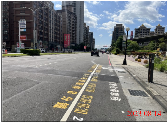
巡查日期地點：112.08.14/ Y23車站 照片說明：路面狀況
