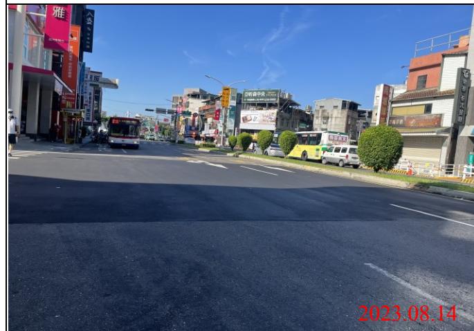
巡查日期地點：112.08.14/ Y21車站 照片說明：路面狀況
