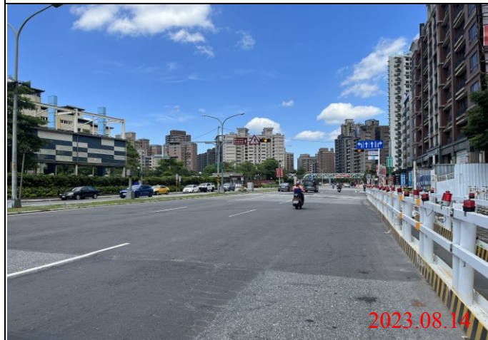
巡查日期地點：112.08.14/ Y23車站 照片說明：路面狀況
