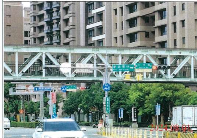
巡查日期地點：113.08.01/ Y23車站 照片說明：牌面設置狀況
