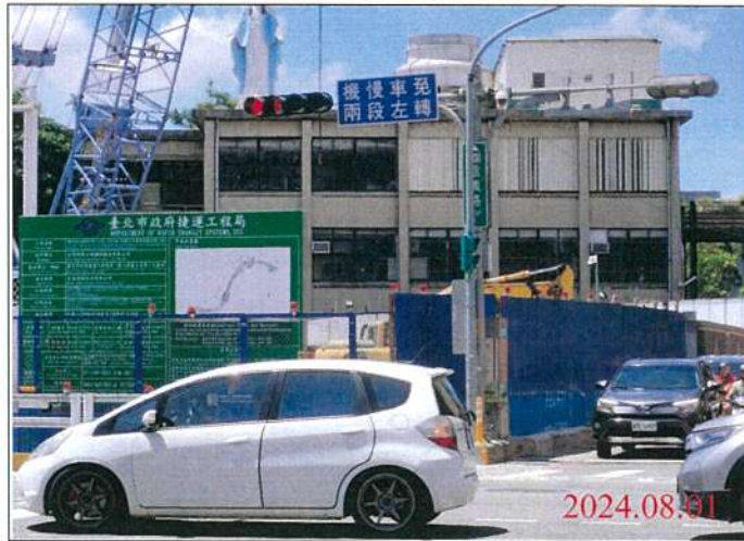
巡查日期地點：113.08.01/ Y21車站 照片說明：牌面設置狀況
