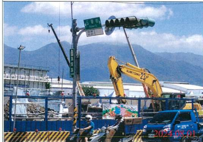
巡查日期地點：113.08.01/ Y22車站 照片說明：牌面設置狀況
