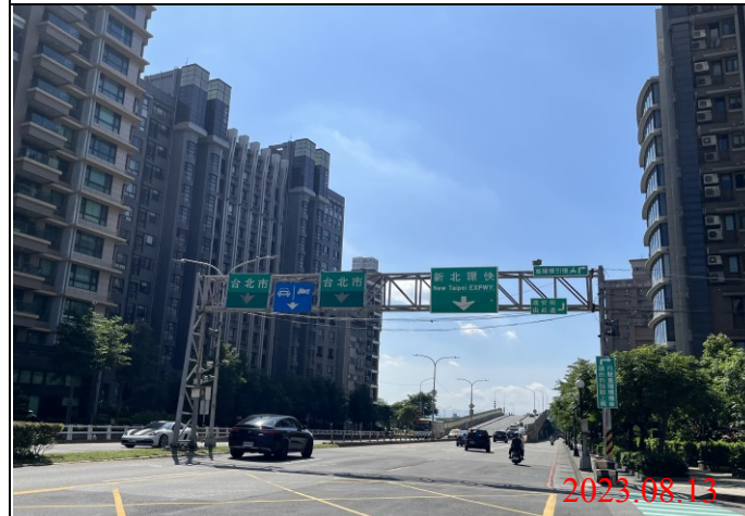
巡查日期地點：112.08.13/ Y23車站 照片說明：牌面設置狀況
