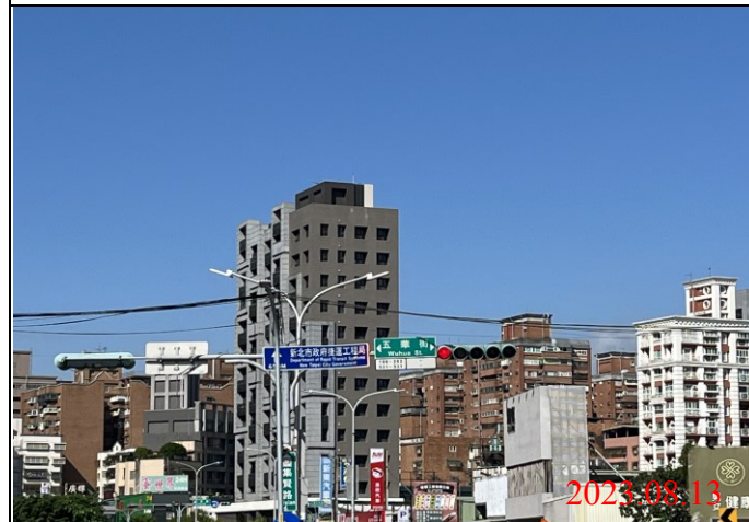
巡查日期地點：112.08.13/ Y22車站 照片說明：牌面設置狀況
