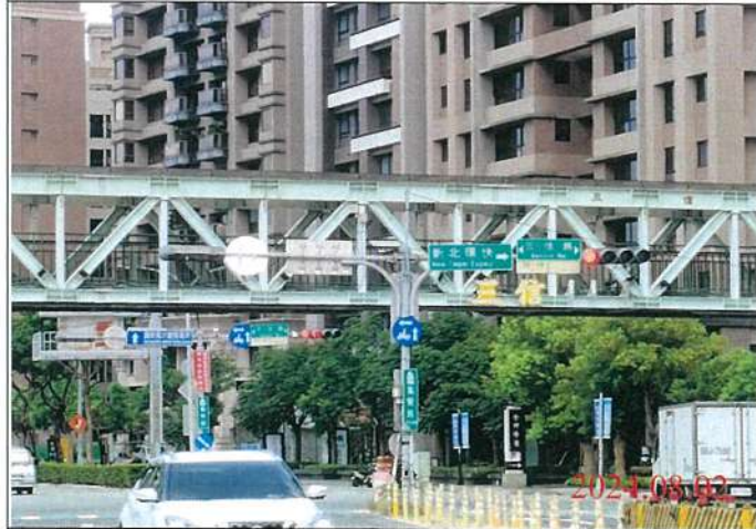
巡查日期地點：113.08.02/ Y23車站 照片說明：牌面設置狀況
