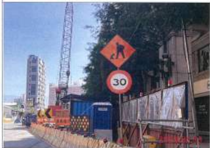
巡查日期地點：113.08.03/ Y22車站 照片說明：牌面設置狀況
