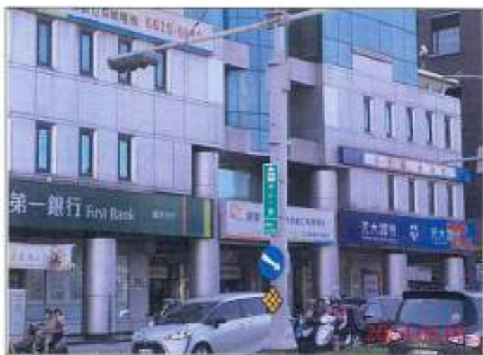
巡查日期地點：113.08.03/ Y21車站 照片說明：牌面設置狀況
