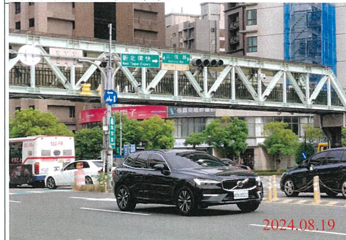
巡查日期地點：113.08.19 / Y23車站 照片說明：牌面設置狀況
