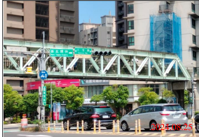
巡查日期地點：113.08.25/ Y23車站 照片說明：牌面設置狀況
