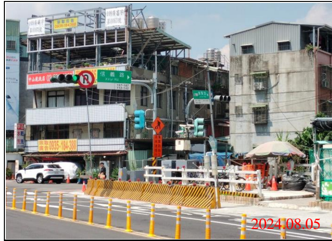
巡查日期地點：113.08.05/ Y21車站 照片說明：牌面設置狀況
