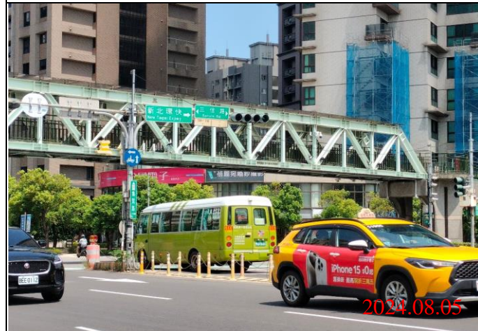
巡查日期地點：113.08.05/ Y23車站 照片說明：牌面設置狀況
