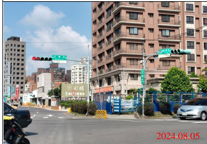
巡查日期地點：113.08.05/ Y22車站 照片說明：牌面設置狀況
