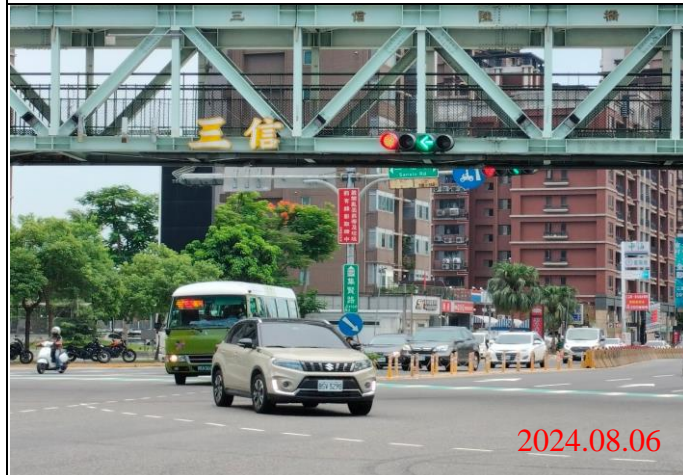
巡查日期地點：113.08.06/ Y23車站 照片說明：牌面設置狀況
