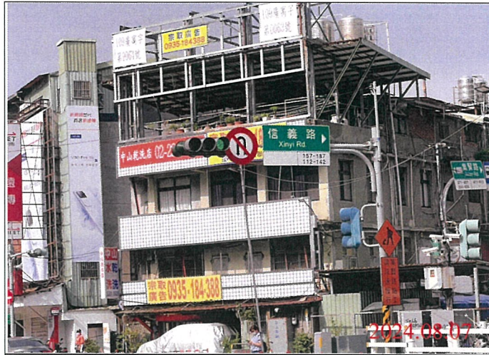
巡查日期地點：113.08.07/ Y21車站 照片說明：牌面設置狀況
