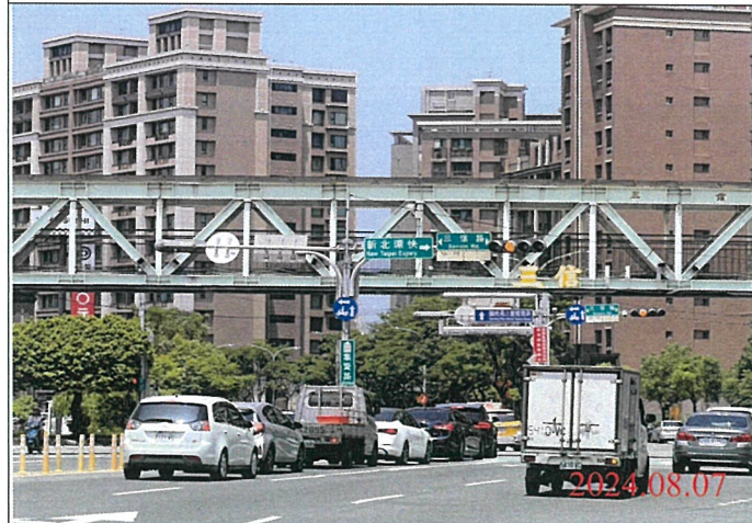
巡查日期地點：113.08.07/ Y23車站 照片說明：牌面設置狀況
