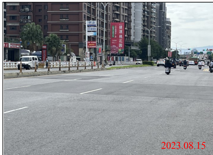
巡查日期地點：112.08.15/ Y23車站 照片說明：路面狀況
