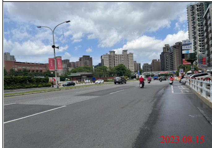
巡查日期地點：112.08.15/ Y23車站 照片說明：路面狀況
