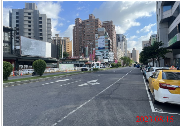
巡查日期地點：112.08.15/ Y21車站 照片說明：路面狀況
