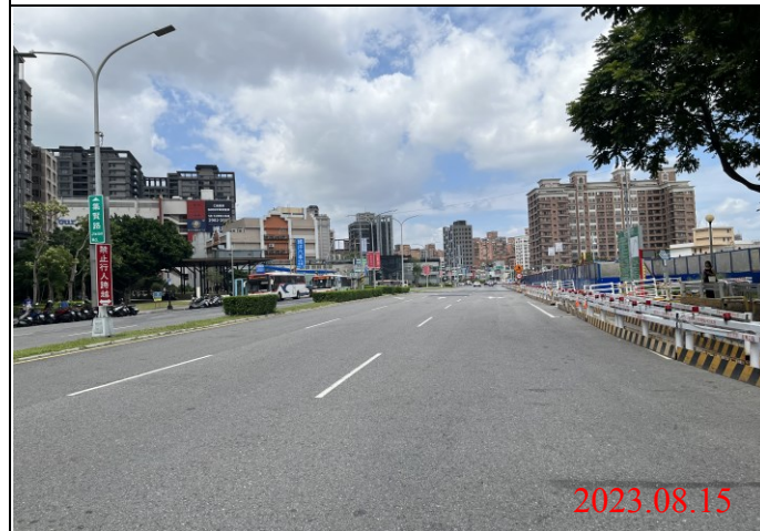
巡查日期地點：112.08.15/ Y22車站 照片說明：路面狀況
