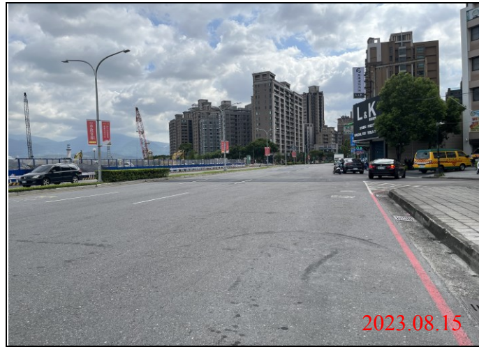
巡查日期地點：112.08.15/ Y22車站 照片說明：路面狀況
