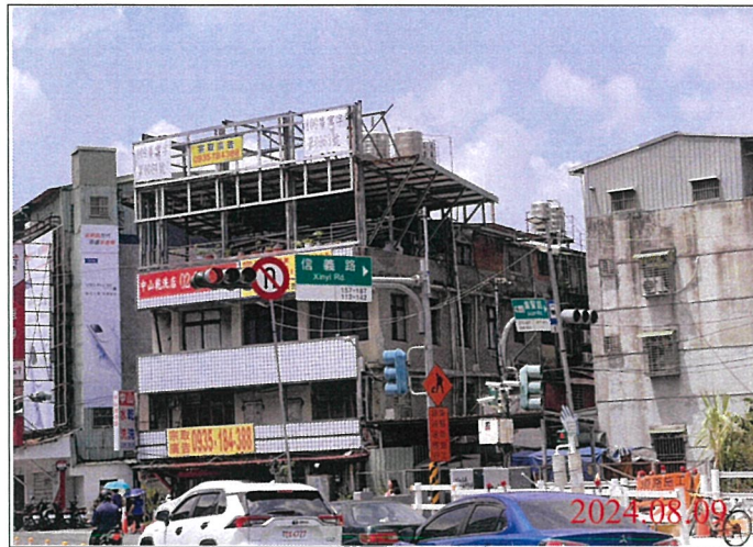
巡查日期地點：113.08.09/ Y21車站 照片說明：牌面設置狀況
