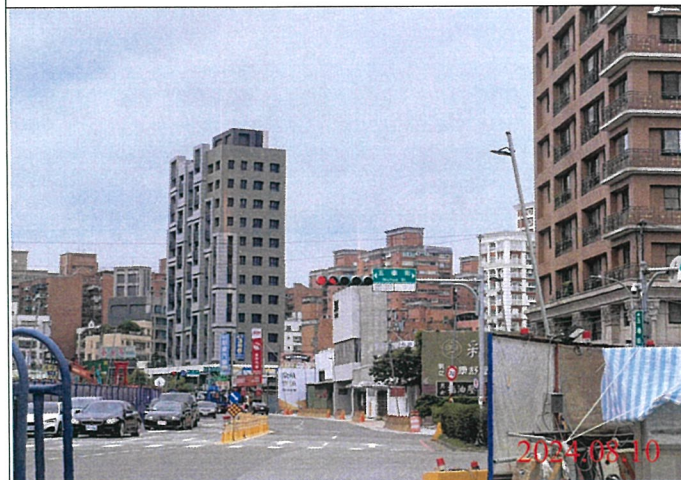
巡查日期地點：113.08.10/ Y22車站
