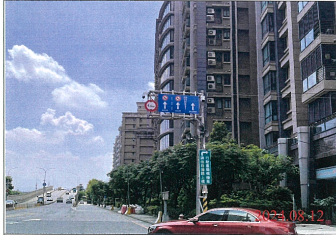
巡查日期地點：113.08.12/ Y23車站 照片說明：牌面設置狀況
