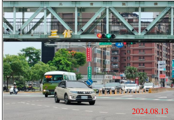
巡查日期地點：113.08.13/ Y23車站 照片說明：牌面設置狀況
