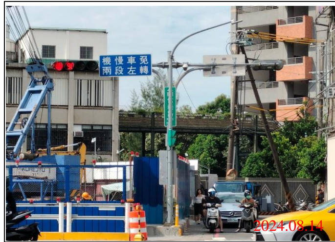
巡查日期地點：113.08.14/ Y21車站 照片說明：牌面設置狀況
