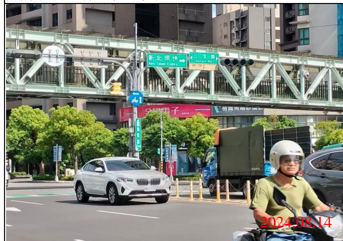
巡查日期地點：113.08.14/ Y23車站 照片說明：牌面設置狀況
