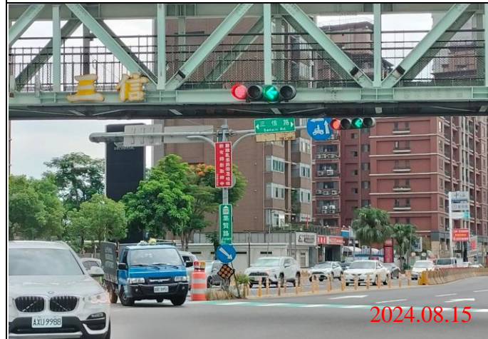
巡查日期地點：113.08.15/ Y23車站 照片說明：牌面設置狀況
