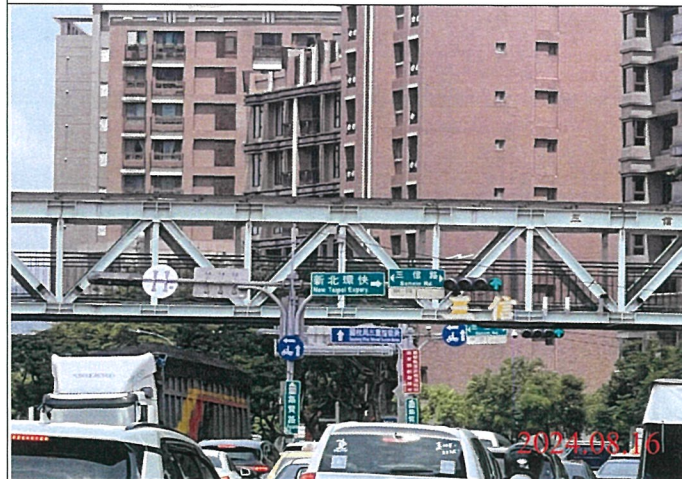
巡查日期地點：113.08.16/ Y23車站 照片說明：牌面設置狀況
