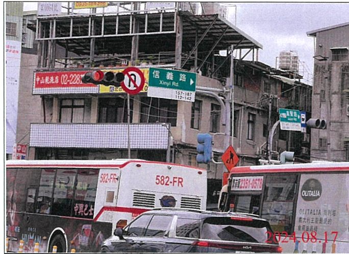
巡查日期地點：113.08.17/ Y21車站 照片說明：牌面設置狀況
