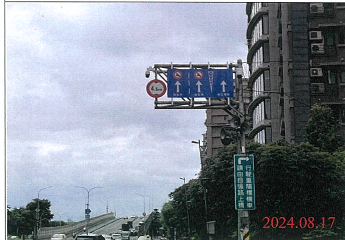
巡查日期地點：113.08.17/ Y23車站 照片說明：牌面設置狀況
