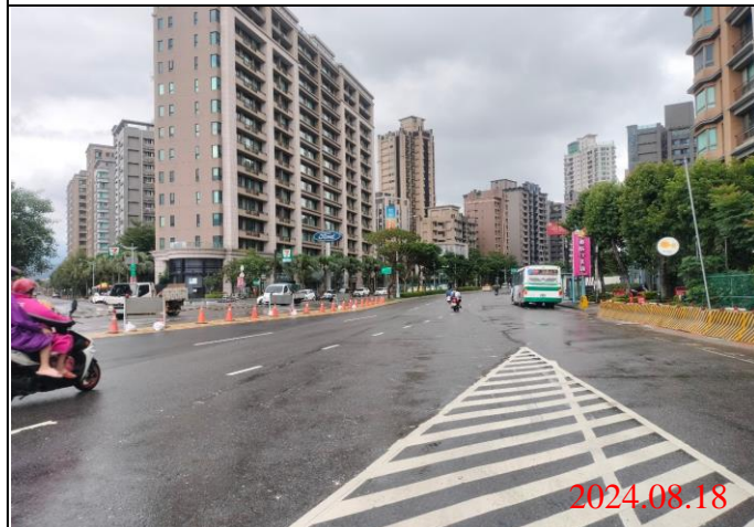
巡查日期地點：113.08.18/ Y22車站 照片說明：路面狀況
