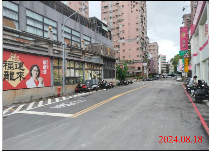
巡查日期地點：113.08.18/ Y21車站 照片說明：路面狀況
