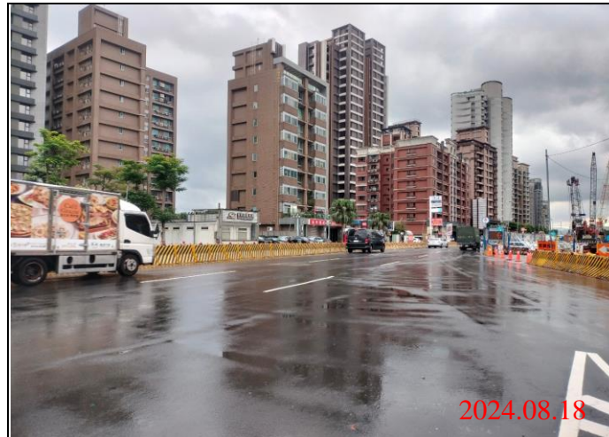
巡查日期地點：113.08.18/-23車站 照片說明：路面狀況
