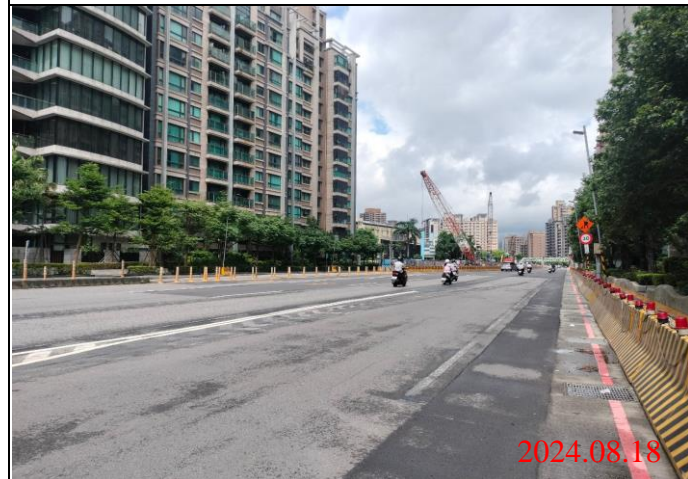
巡查日期地點：113.08.18/ Y23車站 照片說明：路面狀況
