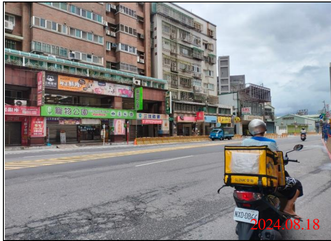
巡查日期地點：113.08.18/ Y22車站 照片說明：路面狀況
