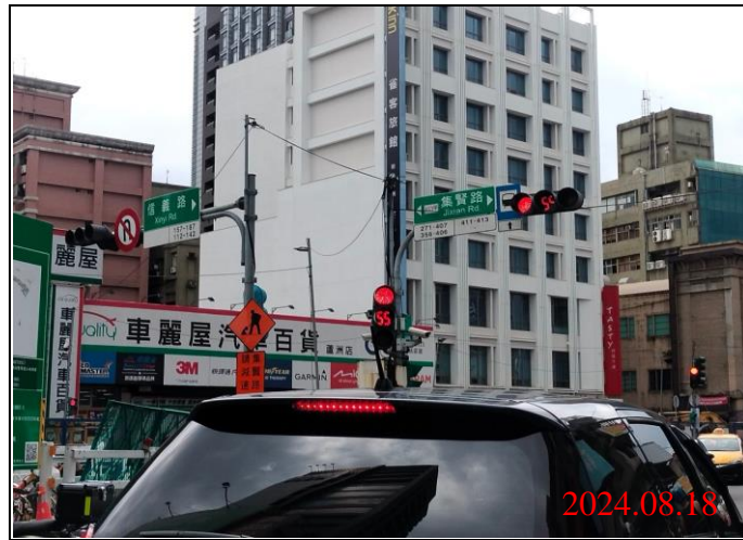
巡查日期地點：113.08.18/ Y21車站 照片說明：牌面設置狀況
