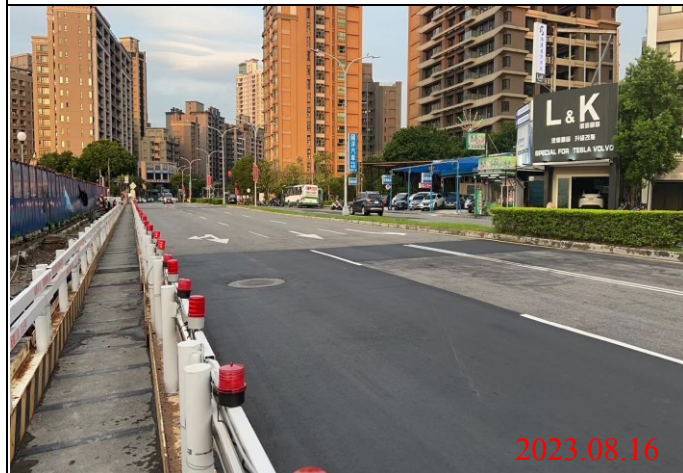
巡查日期地點：112.08.16/ Y22車站 照片說明：路面狀況
