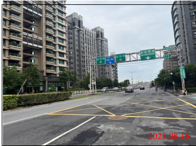
巡查日期地點：112.08.16/ Y23車站 照片說明：路面狀況
