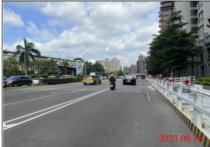
巡查日期地點：112.08.16/ Y23車站 照片說明：路面狀況
