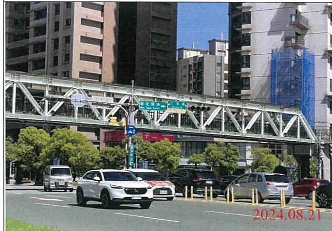
巡查日期地點：113.08.21/ Y23車站 照片說明：牌面設置狀況
