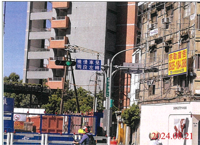
巡查日期地點：113.08.21/ Y21車站 照片說明：牌面設置狀況
