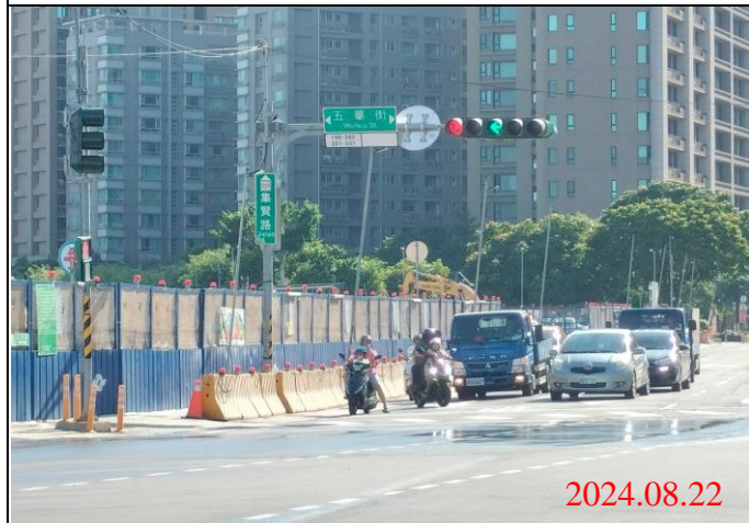
巡查日期地點：113.08.22/ Y22車站 照片說明：牌面設置狀況
