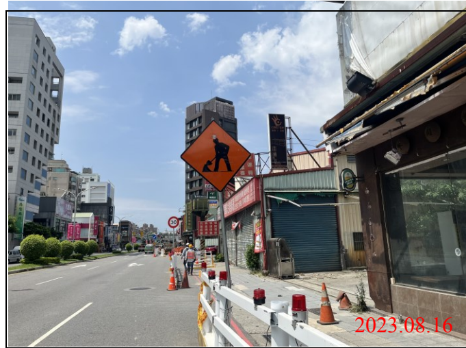
巡查日期地點：112.08.16/ Y21車站 照片說明：牌面設置狀況
