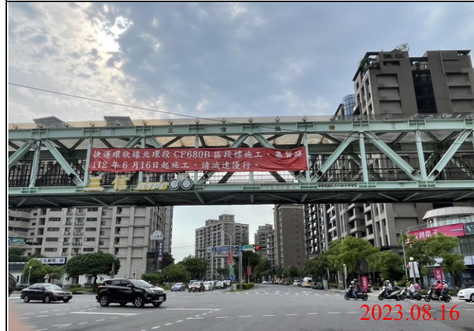
巡查日期地點：112.08.16/ Y23車站 照片說明：牌面設置狀況
