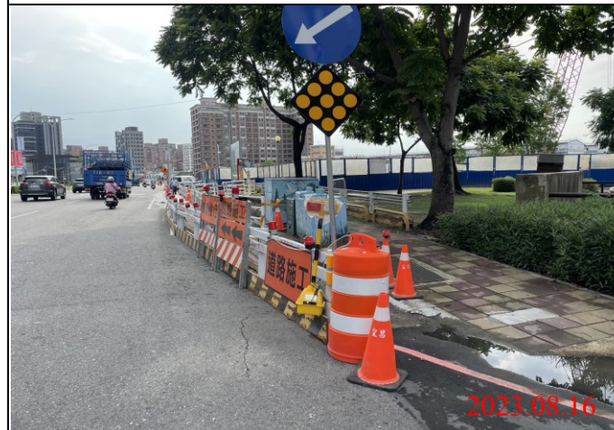
巡查日期地點：112.08.16/ Y22車站 照片說明：牌面設置狀況
