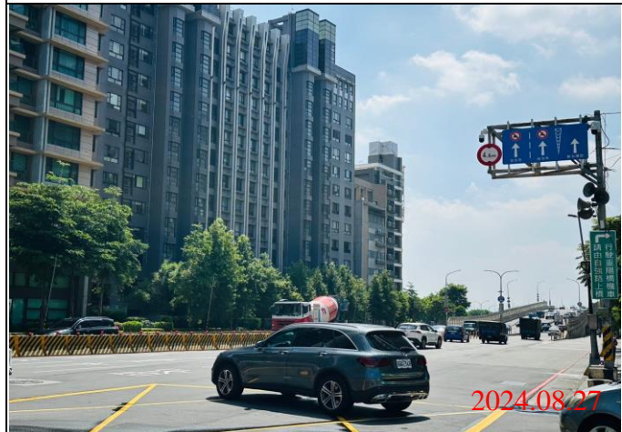
巡查日期地點：113.08.27/ Y23車站 照片說明：牌面設置狀況
