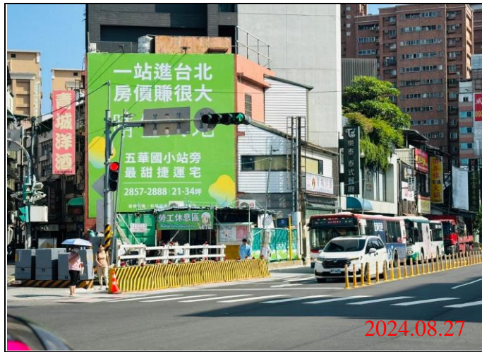
巡查日期地點：113.08.27/ Y21車站 照片說明：牌面設置狀況
