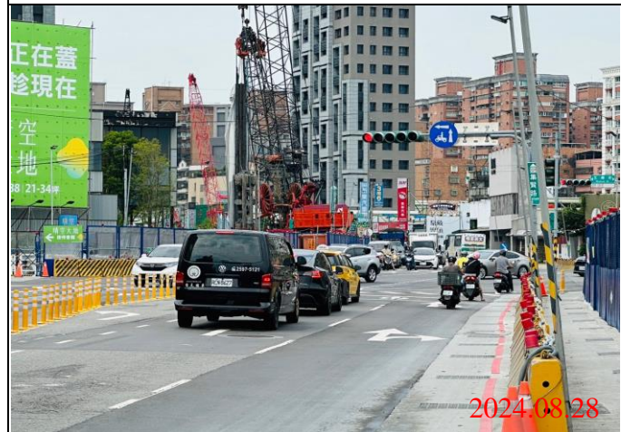
巡查日期地點：113.08.28/ Y22車站 照片說明：牌面設置狀況
