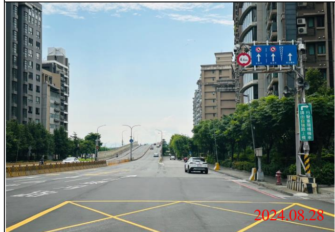
巡查日期地點：113.08.28/ Y23車站 照片說明：牌面設置狀況
