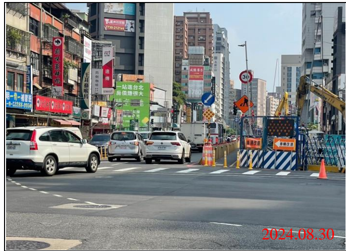
巡查日期地點：113.08.30/ Y21車站 照片說明：牌面設置狀況
