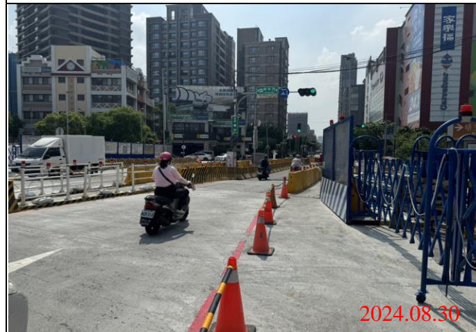
巡查日期地點：113.08.30/ Y22車站 照片說明：牌面設置狀況
