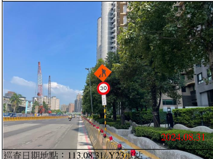
巡查日期地點：113.08.31/ Y22車站 照片說明：牌面設置狀況
