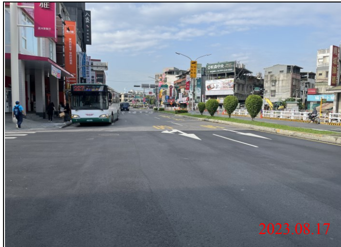
巡查日期地點：112.08.17/ Y21車站 照片說明：路面狀況
