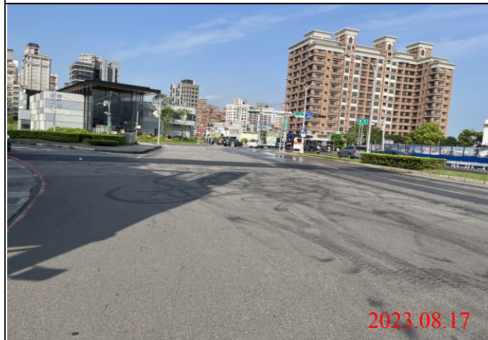
巡查日期地點：112.08.17/ Y22車站 照片說明：路面狀況
