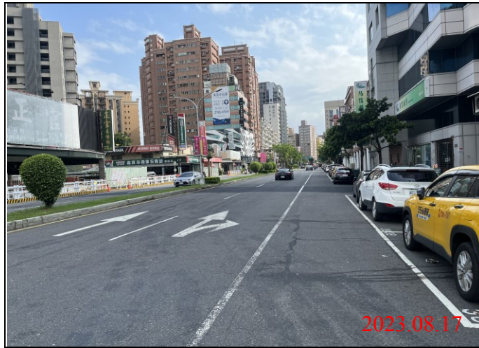
巡查日期地點：112.08.17/ Y22車站 照片說明：路面狀況
