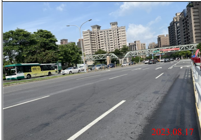
巡查日期地點：112.08.17/ Y23車站 照片說明：路面狀況
