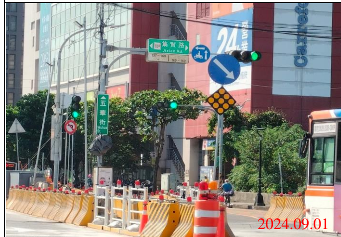
巡查日期地點：113.09.01/ Y22車站 照片說明：牌面設置狀況
