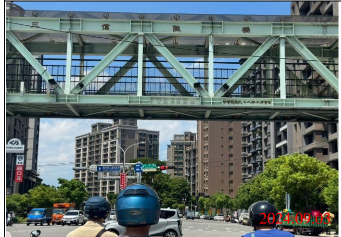
巡查日期地點：113.09.03/ Y23車站 照片說明：牌面設置狀況
