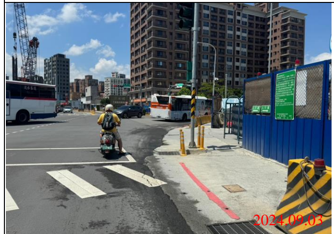
巡查日期地點：113.09.03/ Y22車站 照片說明：牌面設置狀況
