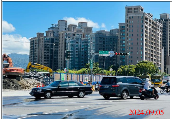
巡查日期地點：113.09.05/ Y22車站 照片說明：牌面設置狀況
