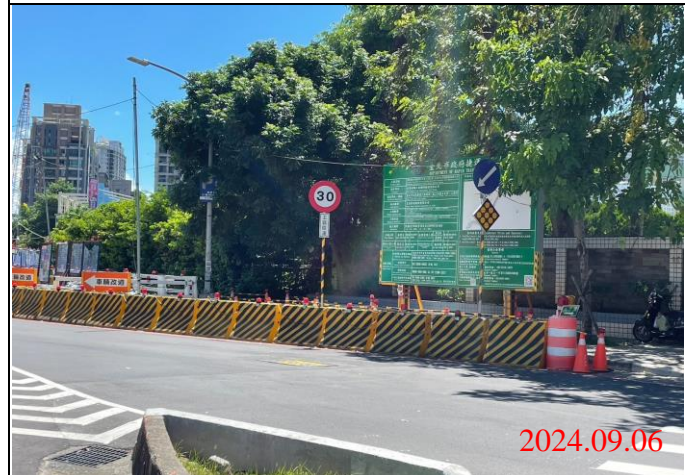
巡查日期地點：113.09.06/ Y23車站 照片說明：牌面設置狀況
