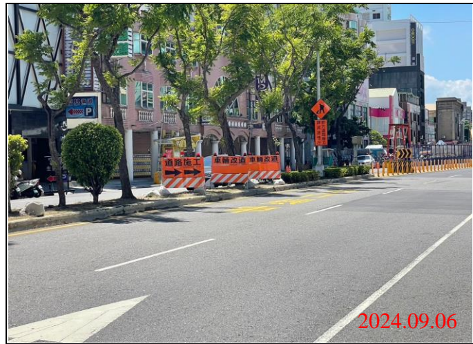
巡查日期地點：113.09.06/ Y21車站 照片說明：牌面設置狀況
