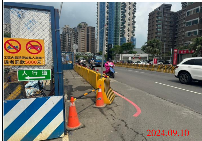
巡查日期地點：113.09.10/ Y23車站 照片說明：牌面設置狀況
