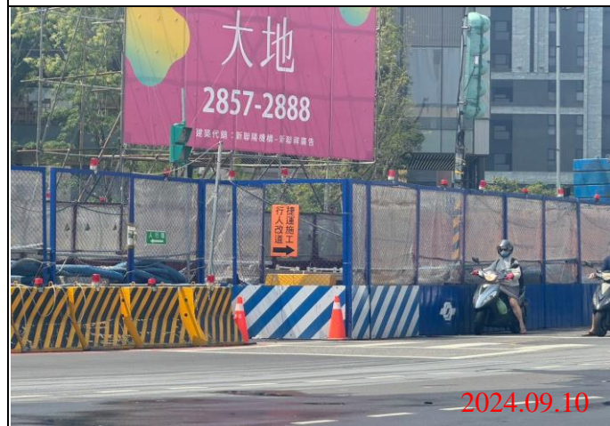
巡查日期地點：113.09.10/ Y22車站 照片說明：牌面設置狀況
