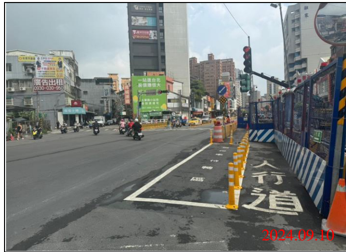
巡查日期地點：113.09.10/ Y21車站 照片說明：牌面設置狀況
